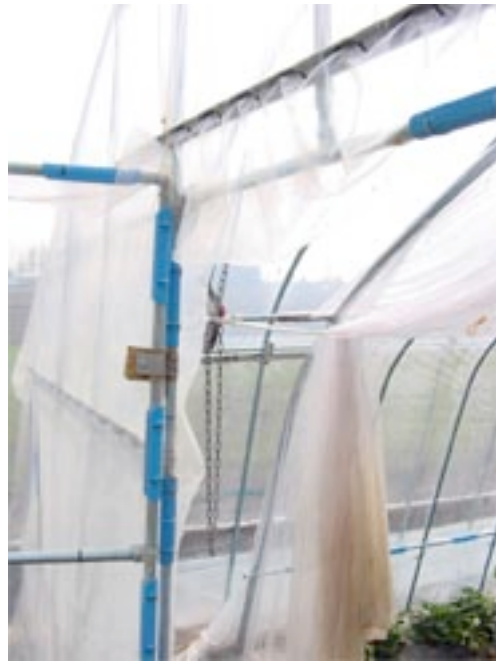
photo2. A 区二重の組まれたビニール温室 ウォーターカーテン装置
